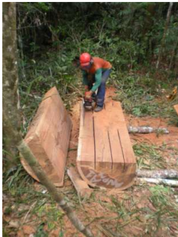
Figura 7 – Retirada de tábuas para retirada das vigas
