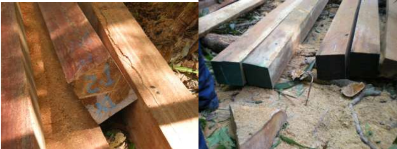
Figura 9 e 10 – Marcação de códigos nas vigas
