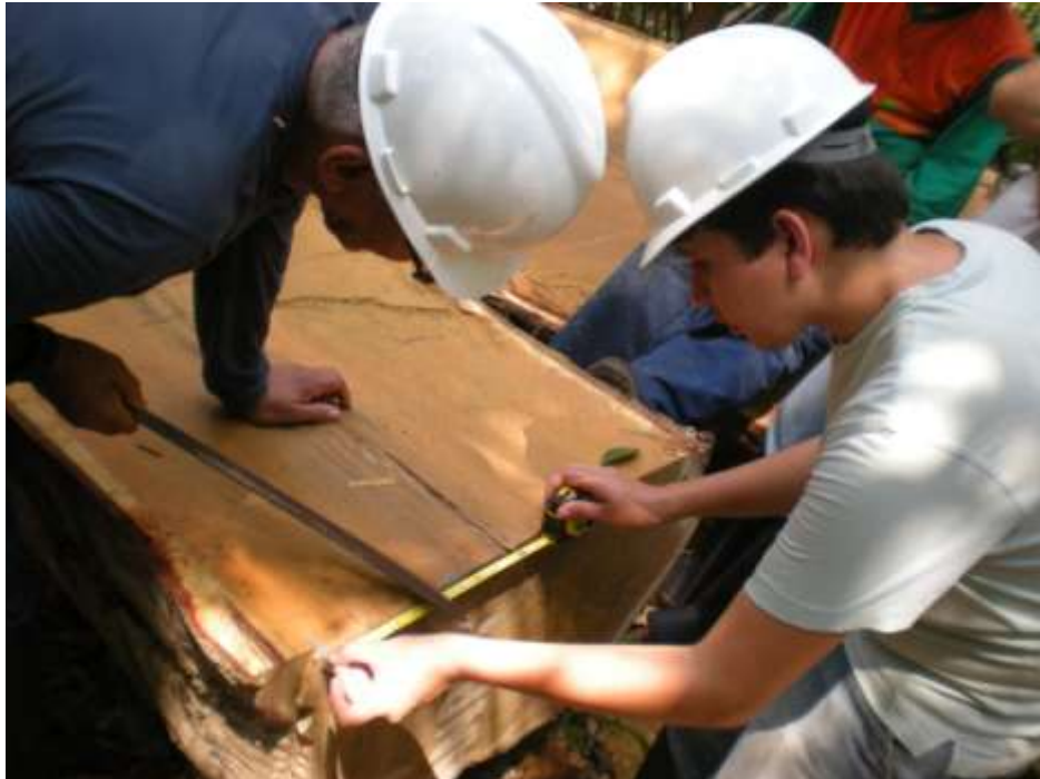
Figura 5 – Marcação das linhas para retirada de vigas
